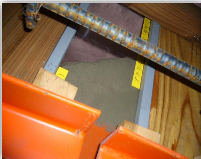
施工充填状況
