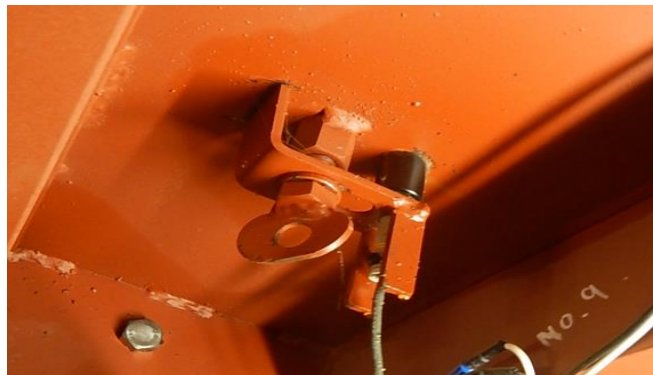
3. 打設状況管理システム → コンクリート感知センサー
